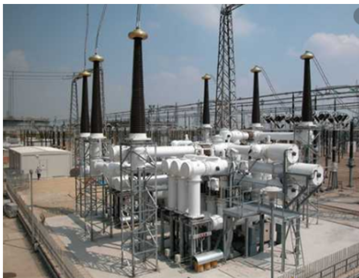
Figura 1: Vista de um transformador de potência trifásico 500 kV/760 kV de 1000 MVA de capacidade.
